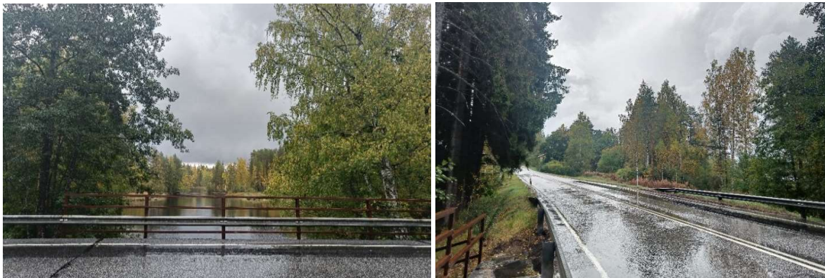
Näkymä kanavalle sillalta (vas.) ja maantietä sillan kohdalla (oik.).
