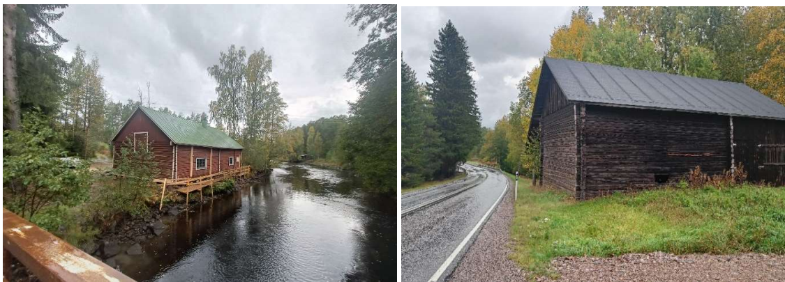
Kanavan länsipuolen maisemaa ja vanha rakennus kanavan etelärannalla (vas.). Toinen vanha rakennus eteläosassa, tien itäpuolella (oik.).
